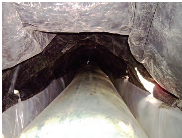
Biodigestor cubierto por plástico negro para mantener temperatura
