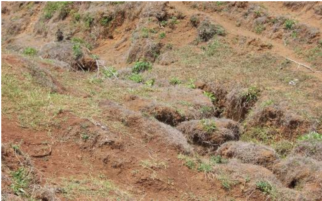
Foto 2: Desagüe natural con alto grado de deterioro por falta de cobertura vegetal. Hojanca, Guanacaste. (Fuente: ASA Hojanca, 2005)
