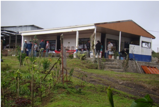
Casa de habitación en la entrada de la Finca Integral Agro eco turística Poró -Pará.
