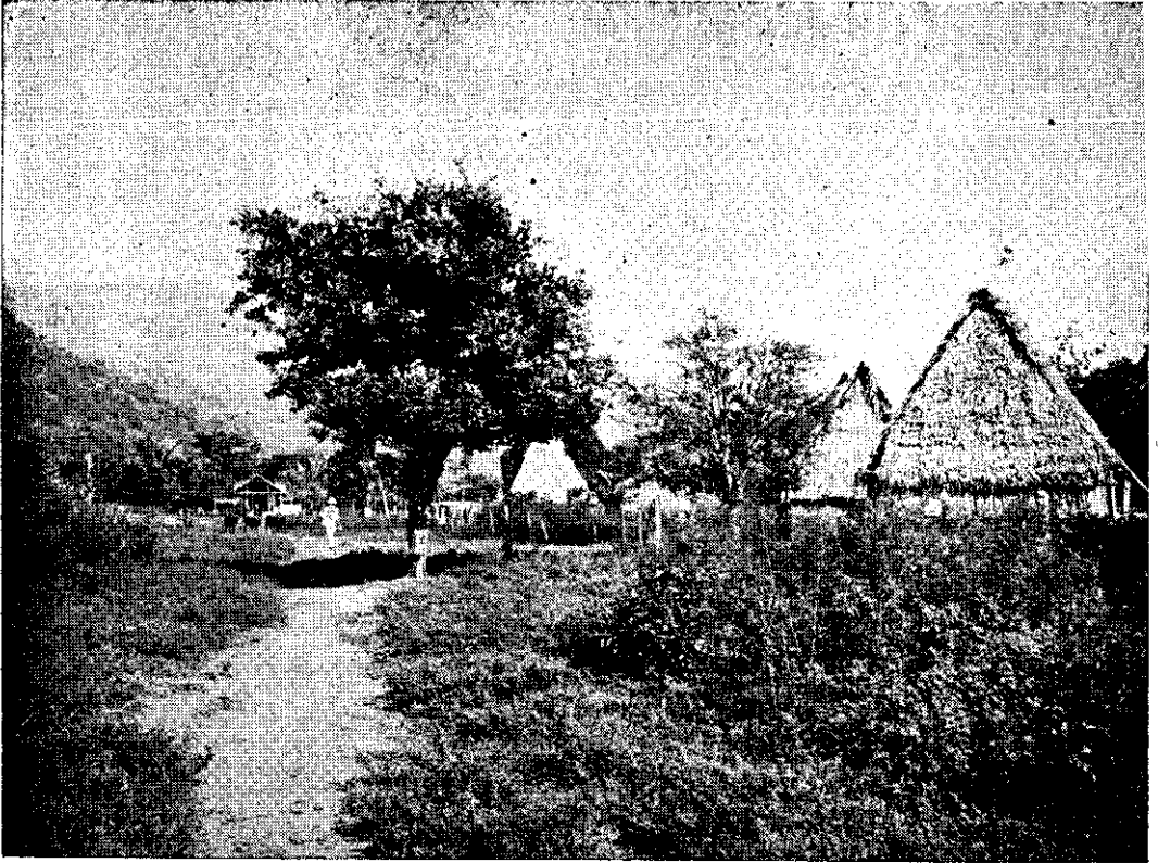
(Fig. 3) Ranchos Techados con hoja de corozo.
